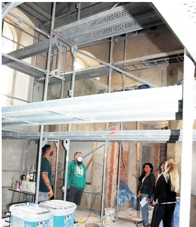
Prohlídka postupu prací uvnitř synagogy při jednom z kontrolních dnů.
