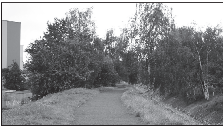
Část cesty podél přivaděče, kterou město zpevnilo.
