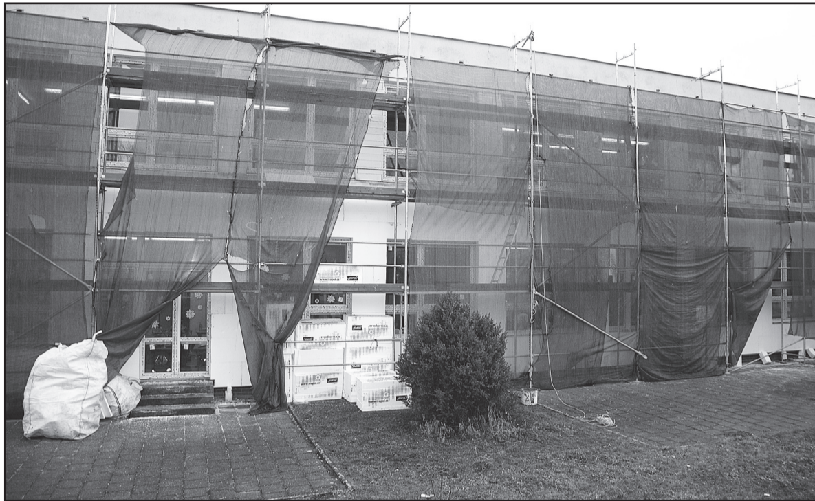
Zateplování základní školy v ulici Budovatelů začalo po přidělení dotace na podzim a bude pokračovat do června. Foto ED
