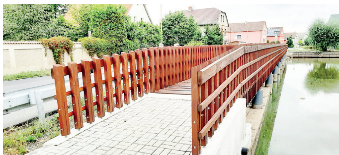
Kompletní nátěr lávky u rybníka v Brezenci v rámci pravidelné údržby.
