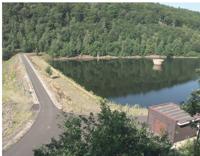
Vodní dílo Jirkov bylo dobudováno v 2. polovině 50. let minulého století. Jeho 55 metrů vysoká sypaná hráz je nejvyšší ve střední Evropě. Nádrž shromažďuje pitnou vodu z řeky Bělý (Bílina) a jejích přítoků.
