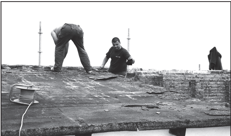
Pavel Pöschel (vpravo) a Tomáš Vachulka z mostecké firmy Cherokee Trade při odstraňování střešní krytiny, střechy a krovů. Foto Luboš Mizun
