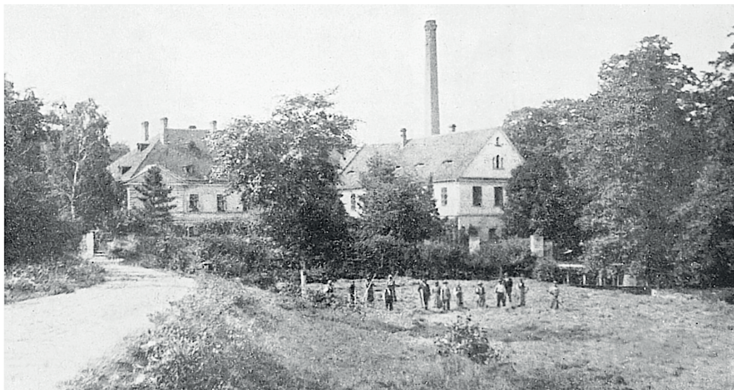
Pod Březencem byla před 250 lety, v roce 1774, na místě staré papírny postavena nová a vyráběla papír až do roku 1948. Sloužila poté více účelům, v současnosti je v ní kovovýroba. Snímek z roku 1900 v pohledu zhruba z chodníku naproti bráně technických služeb. Foto 2x soukromý archiv
