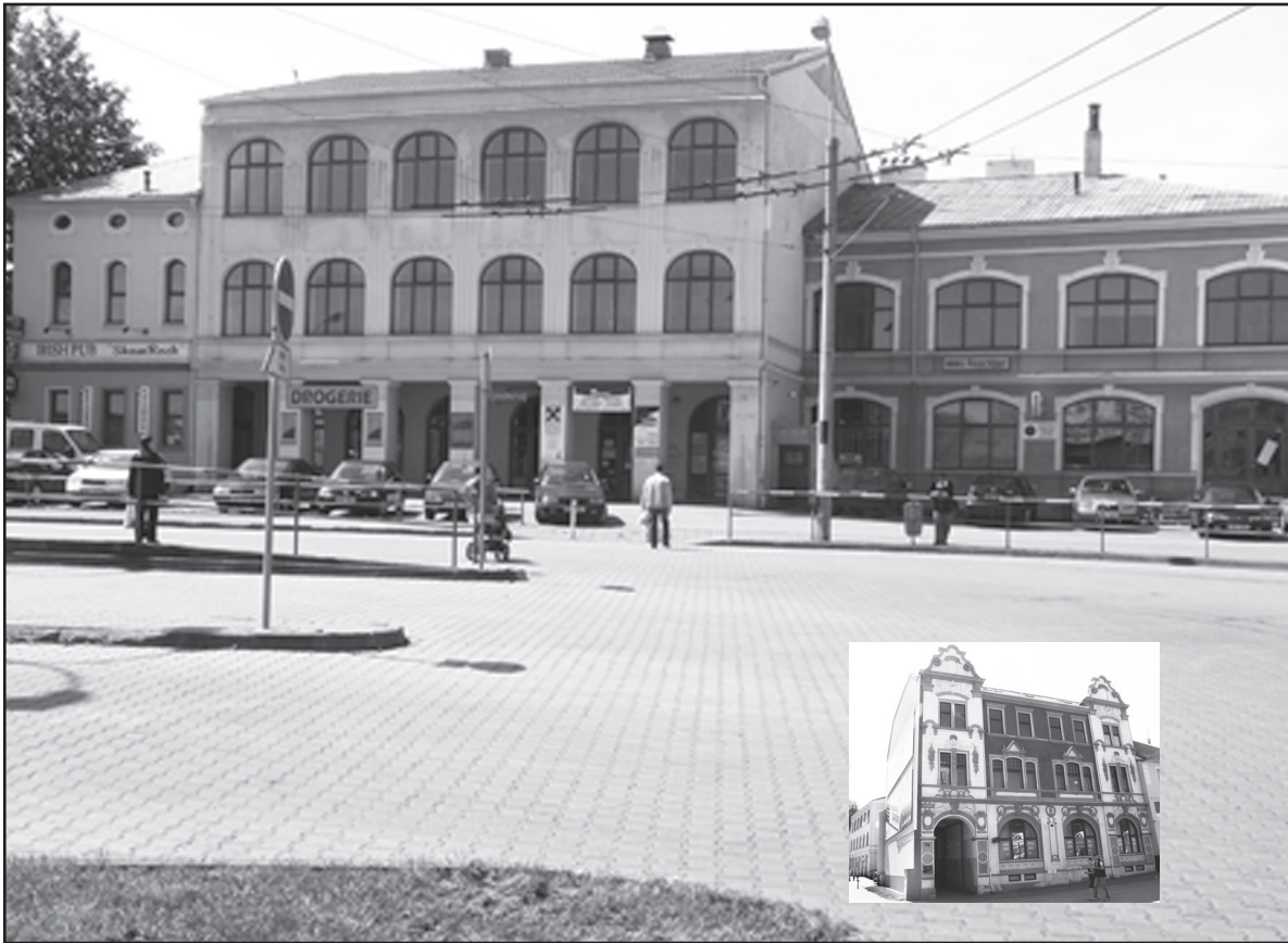
Součástí objektu, kde by měl být nový kulturní dům, je i bývalý hotel Praha (na snímku ve výřezu). Foto Luboš Mizun
