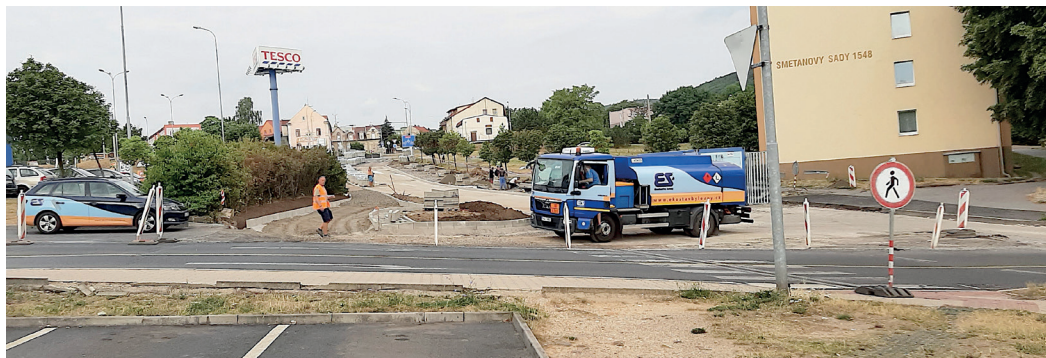
Příkladem letošní úspory je probíhající rekonstrukce komunikací ve Smetanových sadech. Foto V. Vacula
