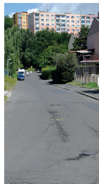
Hornická ulice před opravou
