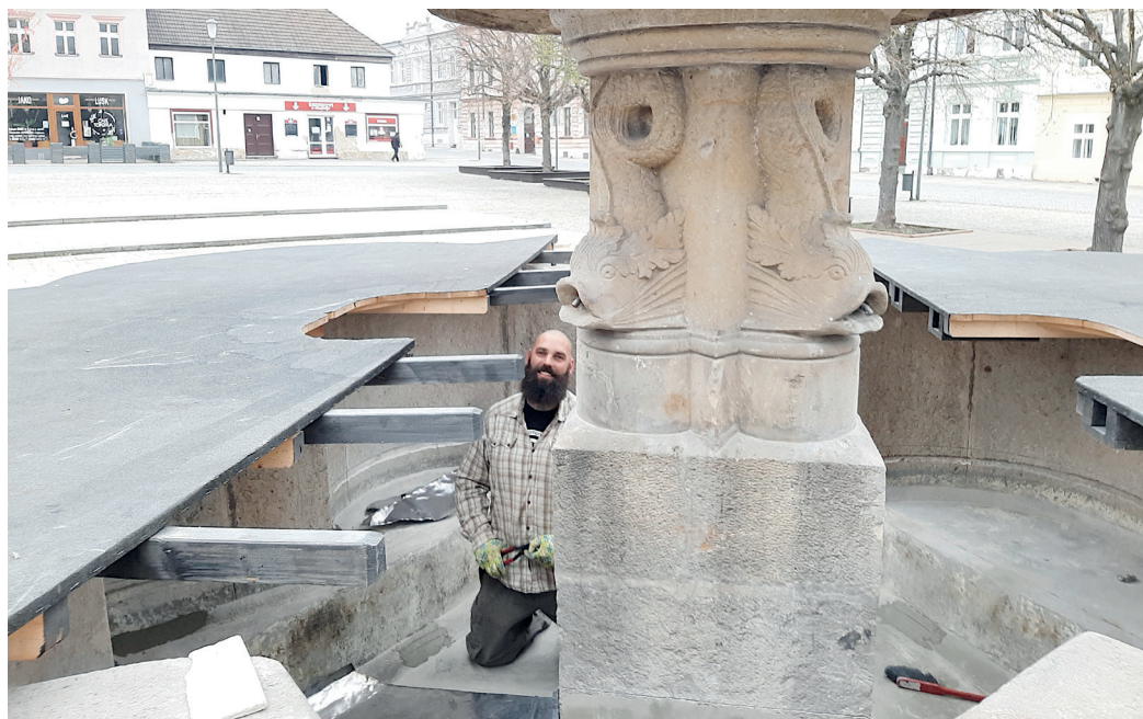
Restaurátor Petr Nič při vykládání vnitřku vany kašny v Jirkově olověnými plechy.
